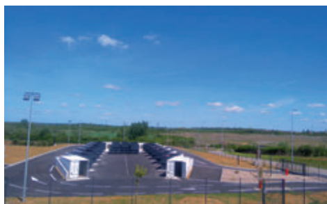
La nouvelle déchetterie sur la ZI de Jarny-Giraumont
